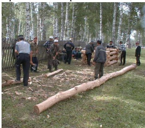
Фото 2. Изготовление сруба. Село Гадельгареево Бурзянского р-на РБ. 2014 г. Из архива ИЭИ УНЦ РАН
